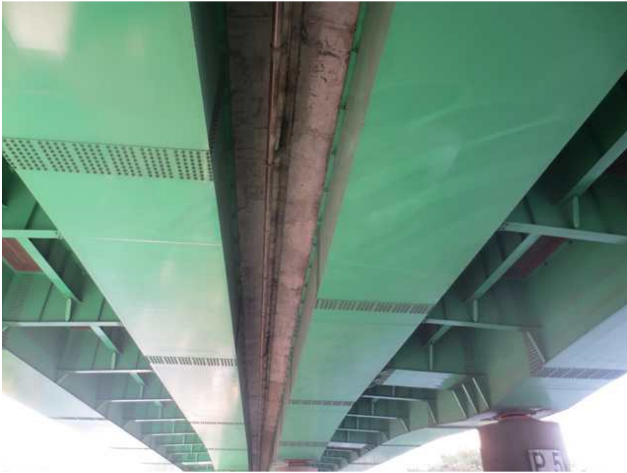
바닥판하면 및 강박스 외부전경
